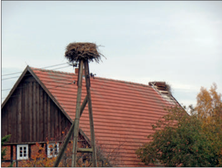
Abb. 3: Storchhorst „Osterloh“ auf Holz-A-Mast mit Metallunterlage in Wahrenberg. Fig. 3: White Stork nest „Osterloh“ on a wooden mast in Wahrenberg.
